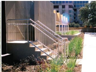
Figura 41: Acceso elevado a zona habitable (FEMA)
