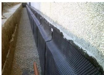
Figura 31: Sistema de drenaje de muro (ferreteriacornellana.com)
