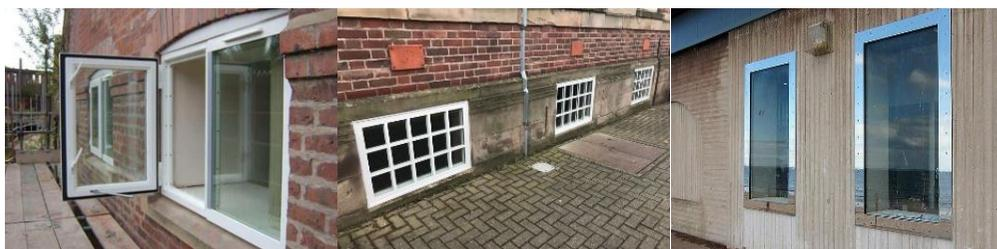
**Figura 22:** Ventana resistente a las inundaciones. Abatible (Mmengineering)
