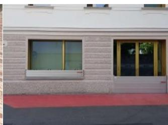
**Figura 21:** Barrera antinundación (Tandem Hse)
