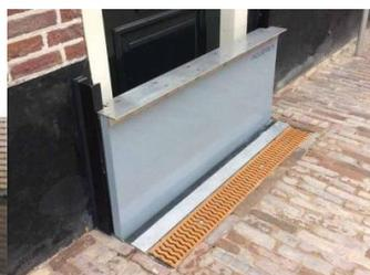
**Figura 20:** Compuerta con autocierrre por empuje de crecida (Aggerès)
