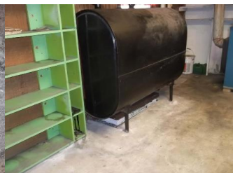
Figura 53: Tanque sobre suelo con apoyos embebidos en losa de hormigón (FEMA)
