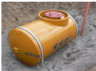
Figura 52: Tanque sobre suelo anclado con correas (cghnordic)
