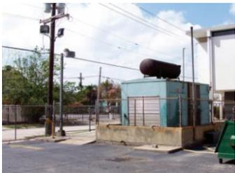
**Figura 49:** Barrera exterior protegiendo generador eléctrico (FEMA)
