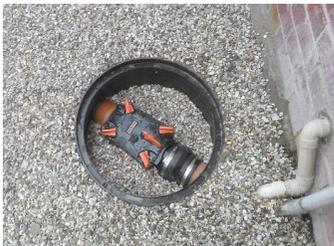
**Figura 64:** Válvula antirretorno (Aquobex)
