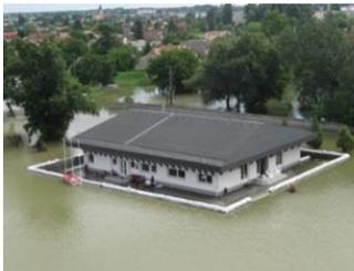
**Figura 5:** Muro permanente estanco de linde de parcela
