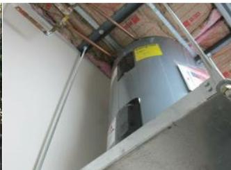
**Figura 45:** Elevar caldera apoyándola sobre plataforma (Waggoner & Ball)
